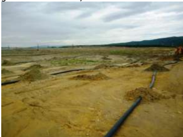
În 2019 instalația de stropire a prafului de pe iazul Tăușani - Boșneag a fost finalizată dar a devenit un "cartof fierbinte" care a costat 1,7 mil. Euro și de care toată lumea vrea să se scape.
